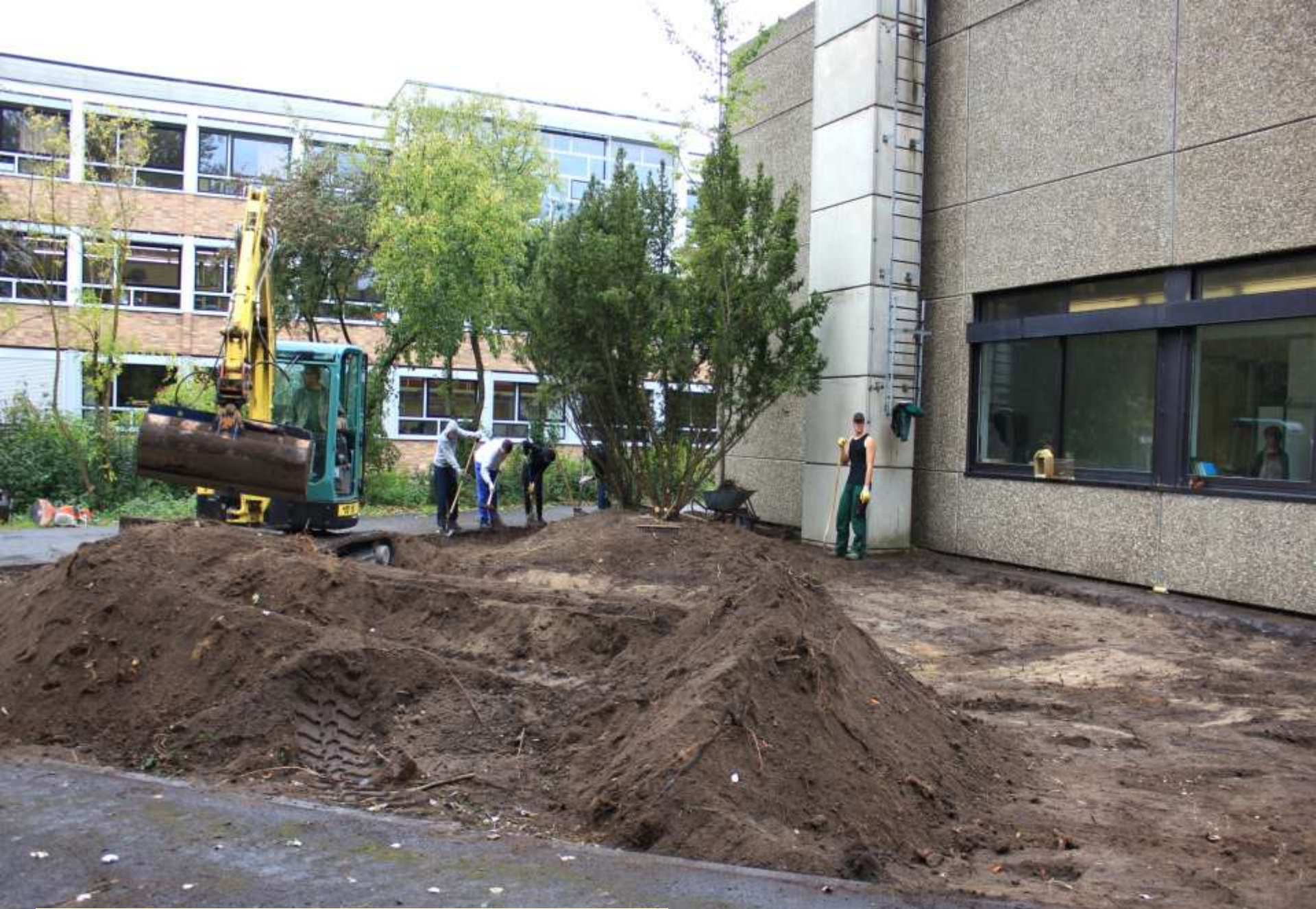
Der Erdaushub liegt zum Abtransport bereit.
