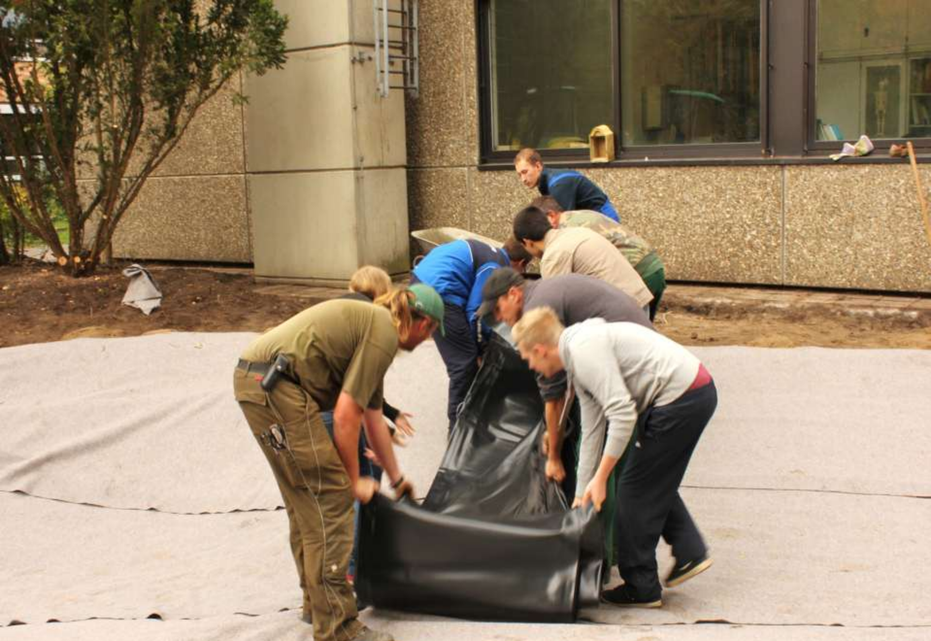
Verlegen der Teichfolie
